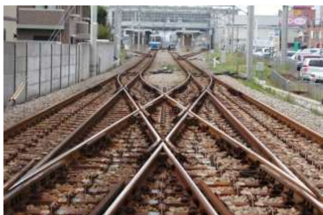
九州旅客鉄道株式会社 筑肥線 筑前前原駅構内 50N12番シーサスクロッシング
